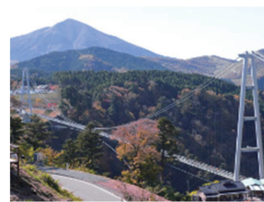
九重夢吊り大橋
